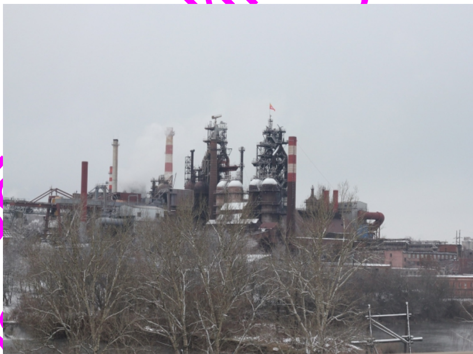
Рисунок 2. ОАО «Косогорский металлургический завод»
