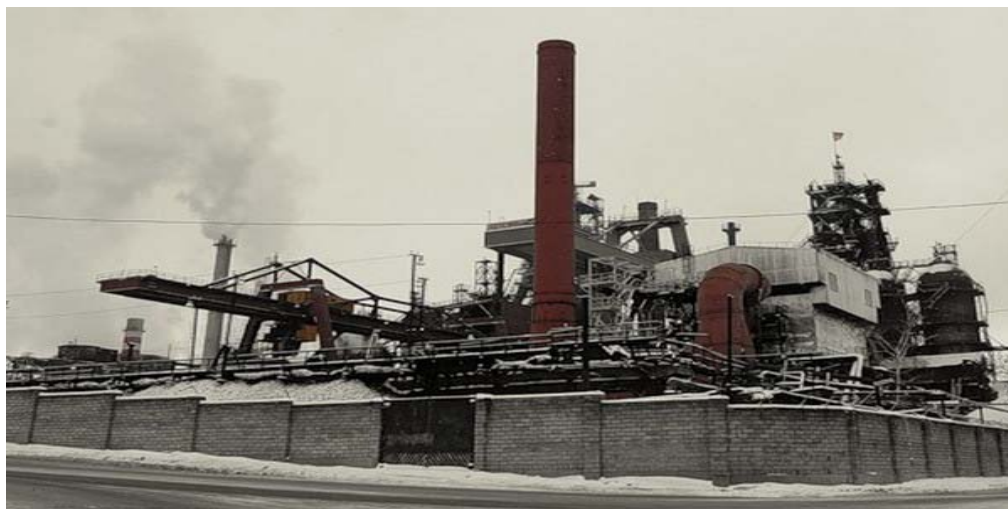
Рисунок 17. ОАО «Косогорский металлургический завод»
